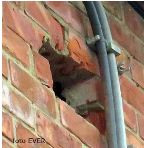
Mohammed kapte een gat door de muur, rakelings langs de voedingskabels van de elektriciteit.
