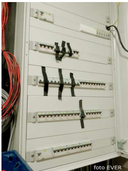
Bord cafetaria - gevoed met 4 x 35 mm 2 en hoofdzekering 80 Ampère. Er zijn 17 tweefasige kringen waarvan 4 geïmmobiliseerd met zwarte plakband - strijdig met artikel 5 AREI -. Er zijn 7 driefasige kringen waarvan de bediening van 3 belemmerd met plakband.
