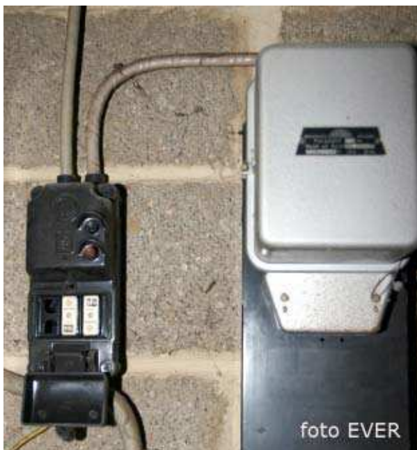
De pulsadis -rechtsboven- en de beveiliging tegen kortsluiting met penzekeringen van 15A -rechts-. Er is geen differentieel, geen van 300 en geen van 30mA!
