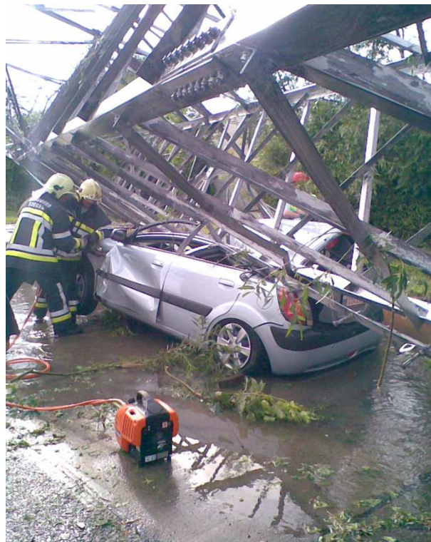
Omgevallen pyloon van een 380 kV lijn te Lier op 21 juli 2009, de bestuurder heeft het er levend vanaf gebracht, de stabiliteit van de pylons blijft uit de debatten gehouden
