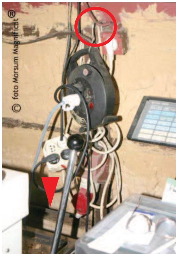
De draden hangen met een metalen haak aan de kabel van het stopcontact (cirkel) de kabel van de deegmenger is als een vioolsnaar gespannen (Pijl)...
