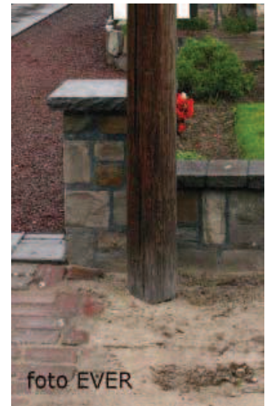
Rond de paal 30cm diep uitgraven zegt J.P.Blomme. Hoe gaan ze dat hier realiseren ? Dit is dan nog een eenvoudig voorbeeld.
