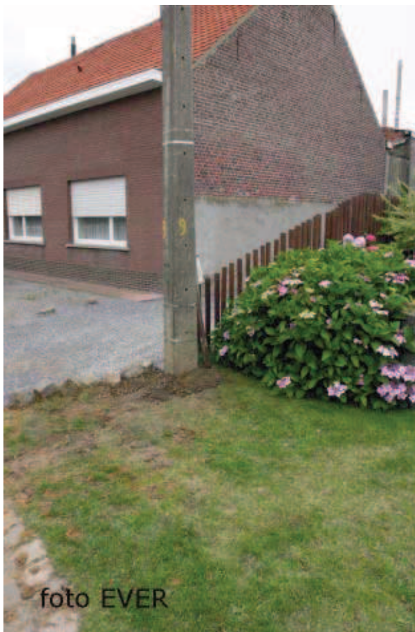
Er werd onmiddellijk een nieuwe -oude- betonnen paal geplaatst.
