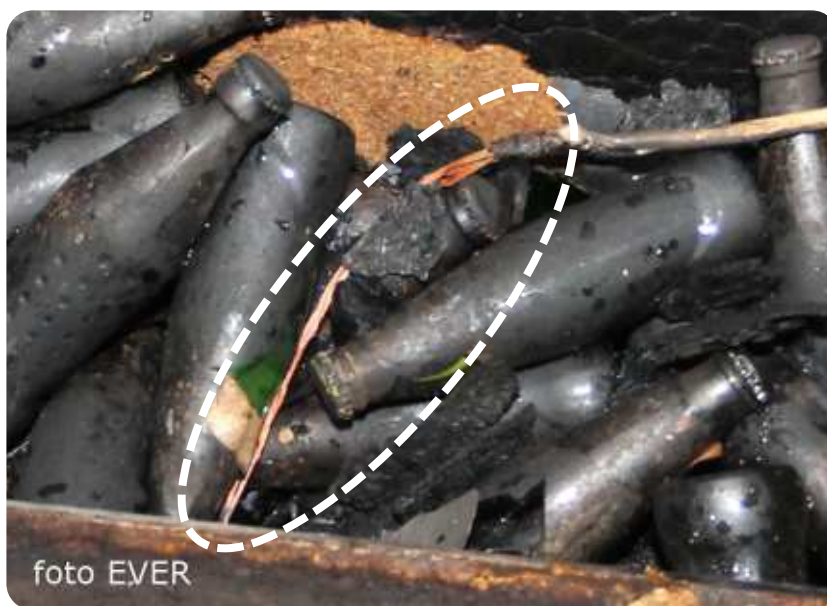
VTLB kabel die op een bepaalde plaats duidelijk beschadigd is en vanaf die plaats plotseling isolatie kwijt is. Het is duidelijk een voedingskabel vanaf het stopcontact.
