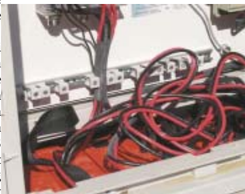
De UPS met onderaan een stel batterijen, als de gassen niet wegkunnen; kleine bommetjes.
