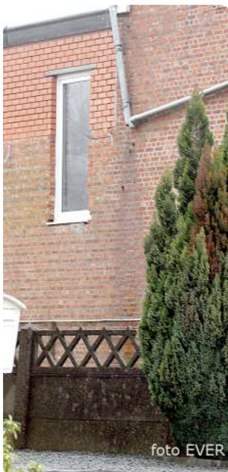
Verbouwingen in 2002-2003 uitgevoerd kregen van Begijnendijk geen weerstand. Het raam op de verdieping reikt tot tegen de vloer en dat is strijdig met art. 7 van het KB van 8 juli 1997.
