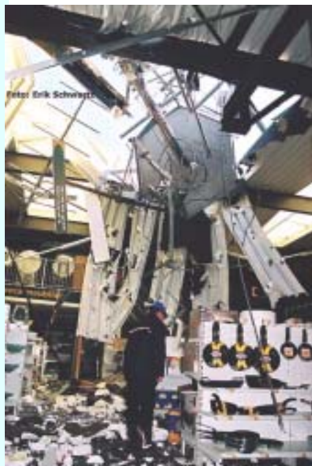
De top van de mast met de antenne boorde zich dwars door het dak van de verkoopsruimte van Sligro, een groothandel voor de horeca.
